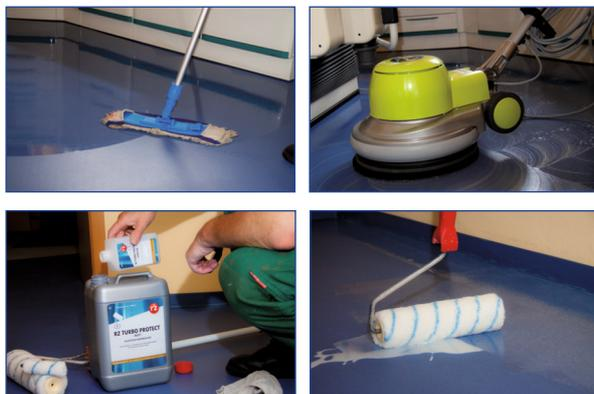
Компоненты А и В, как указано на этикетке, 2 минуты интенсивно перемешивать. На небольшие поверхности наносить маленьким валиком или кистью. Нанести RZ Turbo Protect с помощью соответствующего валика однородным слоем, и затем еще раз прокатать вдоль. Так последовательно покрывается вся поверхность. Защитные или окаймляющие ленты сразу же снять с мебели и пр. Через 12 часов поверхность готова для прохода.
